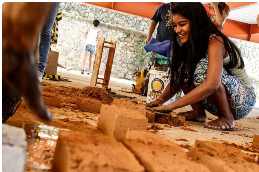
Estudantes aprendem no campus com mestres dos saberes a alinhar muro de pedra e amassar material do adobinho
